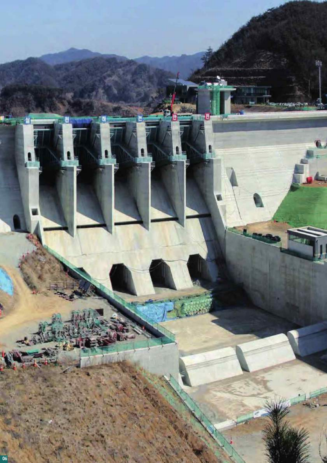
06 영주 다목적댐 건설공사 Construction of Youngju Multipurpose Dam
